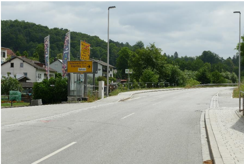
Abbildung 7: Parkfläche und fehlender Übergang in die Engollinger Straße
