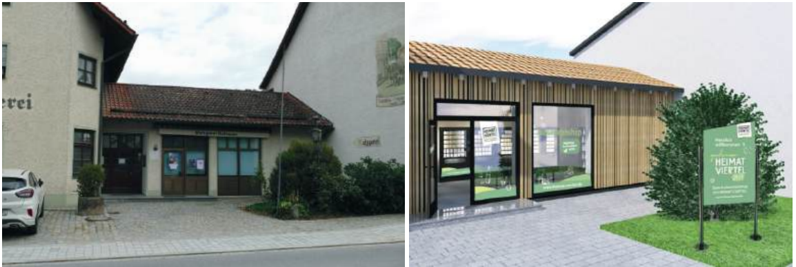
Abb. 97: Ehem. Metzgerei und Skizze für HEIMATVIERTEL Quartier (HEIMATVIERTEL)
