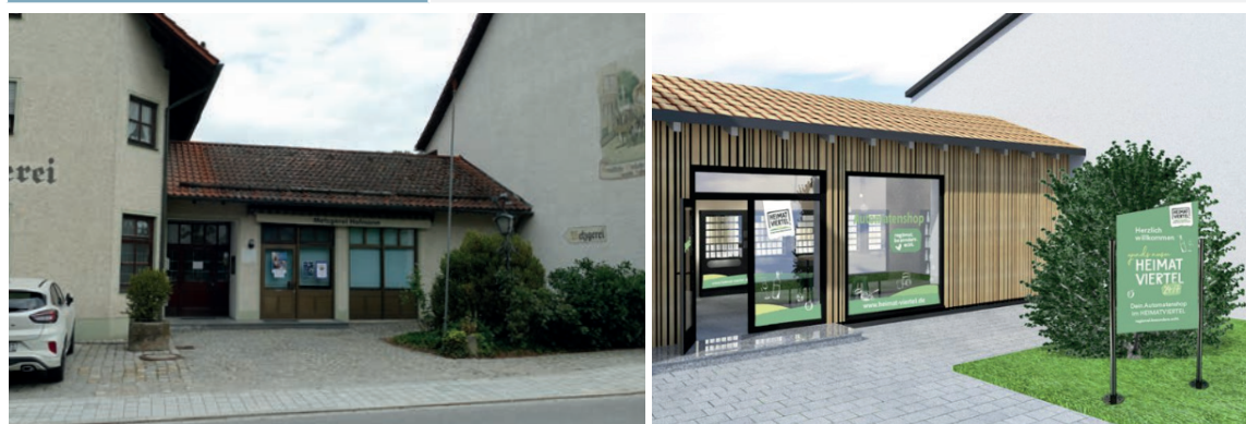
Abb. 98: Ehem. Metzgerei und Skizze für HEIMATVIERTEL Quartier (HEIMATVIERTEL)
