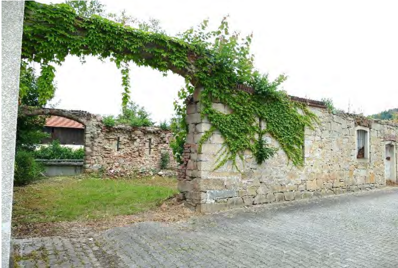
Abbildung 2: Gebäuderuine neben dem Gasthof
